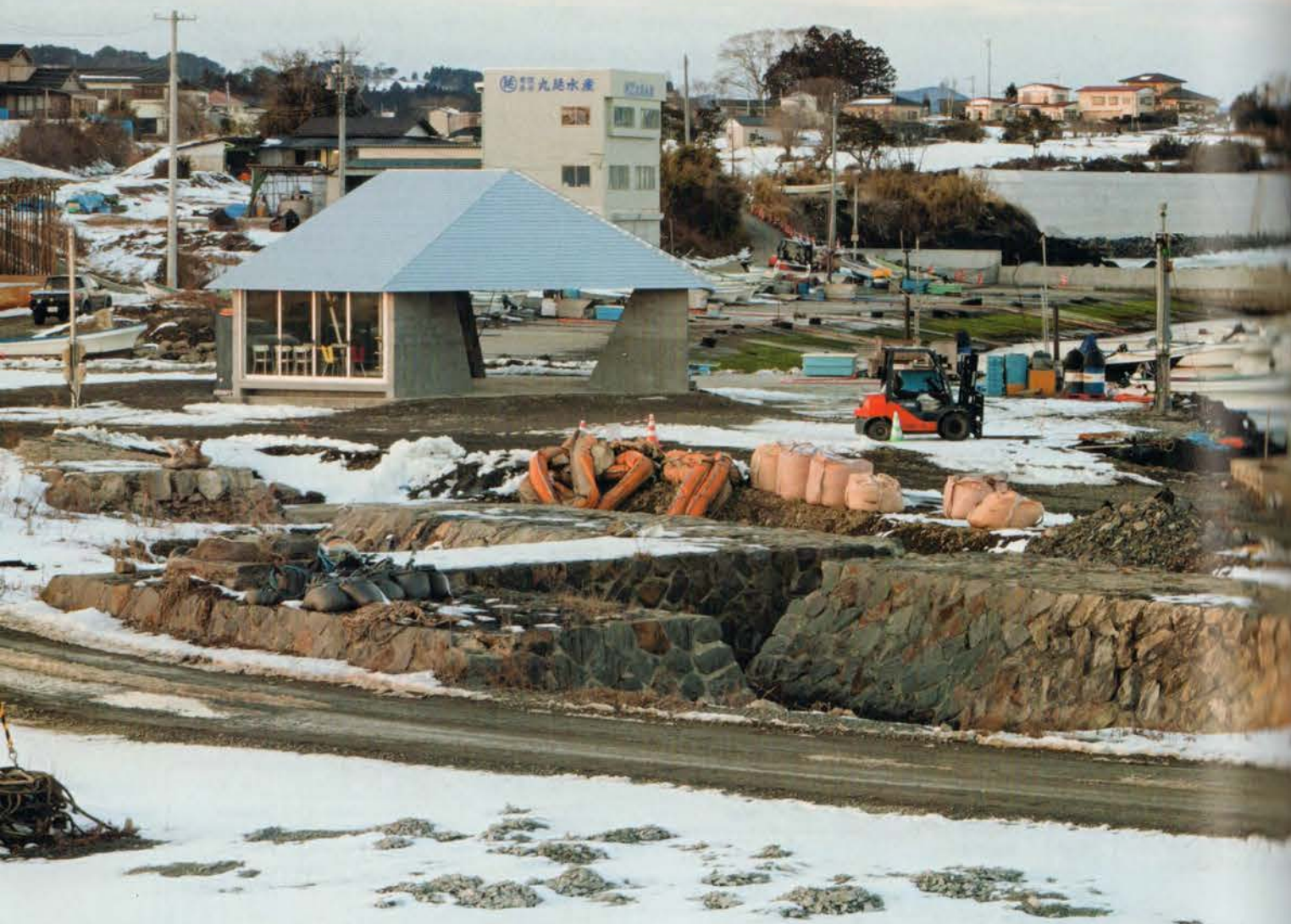
南東より見る。東日本大震災時に発生した津波によって被災した、気仙沼市本吉町大谷に建設された集会所。漁業従事者やその家族の休憩所、イベント会場、魚を販売する市場としても使用する。ロレックス社のメンタープロジェクトの一環として、設計は中国の若手建築家チャオ・ヤン氏が担当、アドバイザーとして妹島和世氏が監修した。
